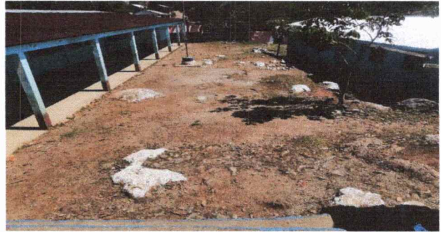
Foto 4: Sustitución de lámina, costaneras, canales de bajadas de agua.
