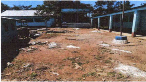
Foto 3: Reparación de entortado patio del establecimiento.
